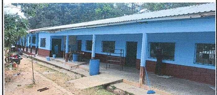
Foto 4: CANALES Y BAJAS DE AGUA PLUVIAL
