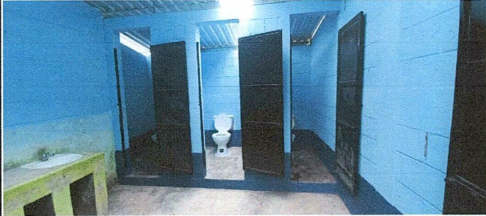
Foto 1: REMOZAMIENTO DE SERVICIOS SANITARIOS
